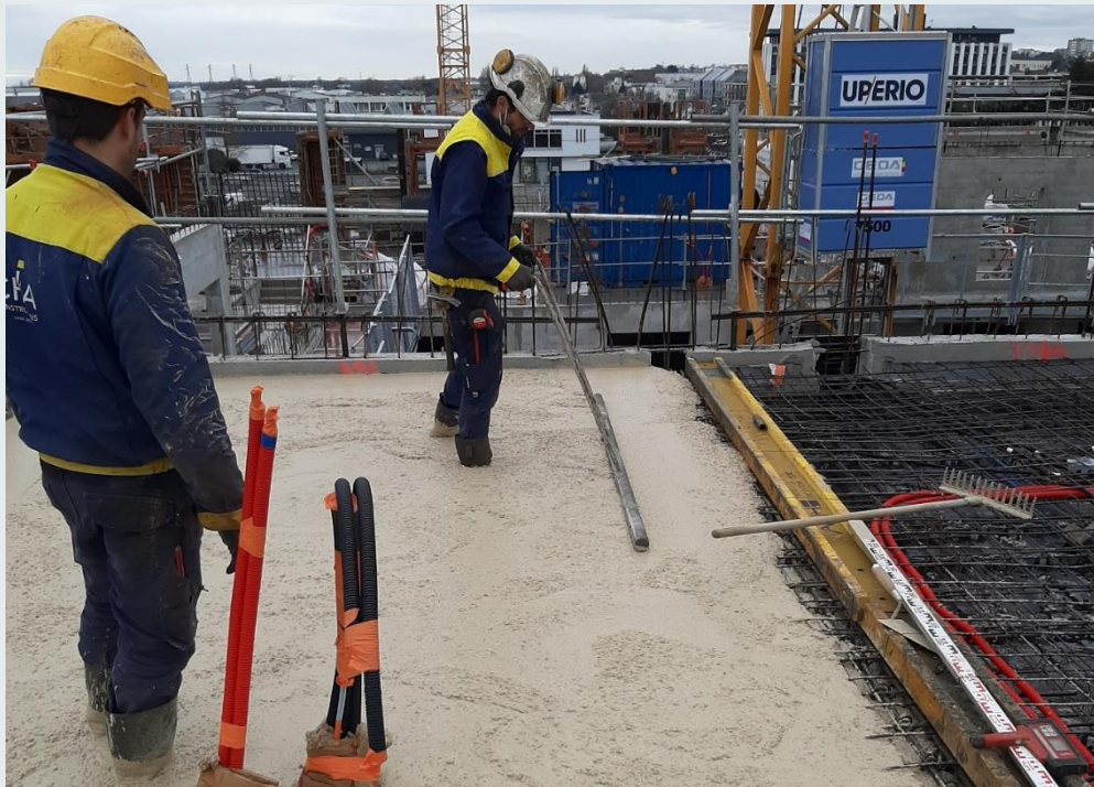
Coulage du béton décarboné sur le chantier de la résidence K2 à Angers
