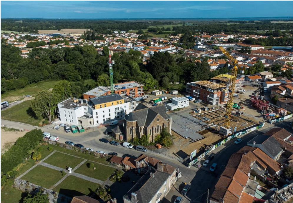
Vue drone du chantier le Clos Saint-François à Saint-Philibert de Grand Lieu
