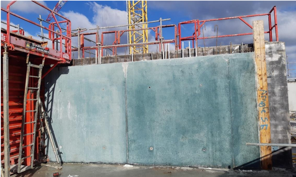
Premier voile en béton armé sans clinker sur l'opération Les Marquises à Nantes
