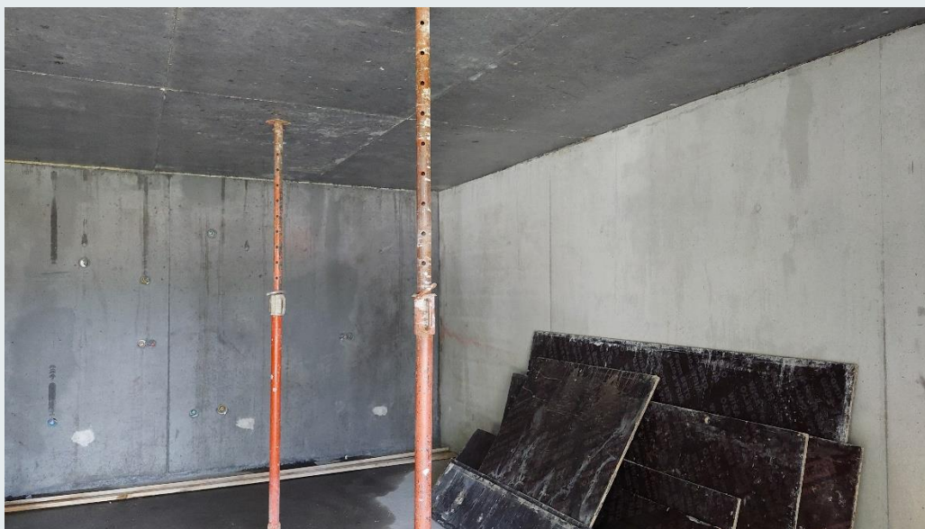
Pose de béton à plus faible empreinte carbone de chez Vicat.
