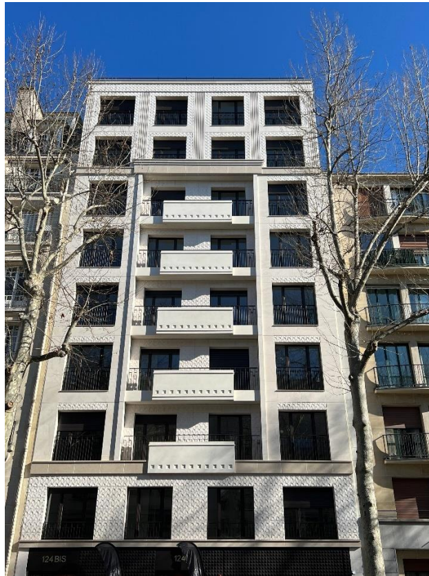
Façade de « La Galerie Peretti » à Neuilly-Sur-Seine
